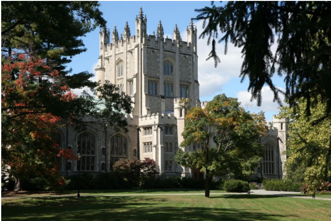
Bild 3: Biblioteket, byggt som en medeltida borg. Denna byggnad ligger centralt på campusområdet och inrymmer imponerande samlingar. Studenterna använder gärna lokalerna som studieplats till långt in på nätterna eftersom det kan vara svårt att få läsa i studentrummen.
